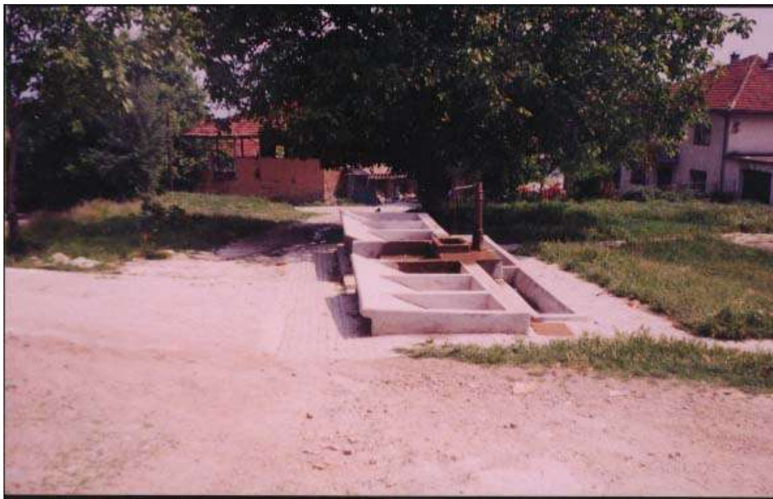
( Фото: Митко Спирски, Бетонските чешми со корита за перење алишта и черги на Костоо во Лешок во 2004 г.) ( Photo: Mitko Spiroski, Concrete fountains with washtubs clothe and rags-Kostoo, Lesok in 2004)
